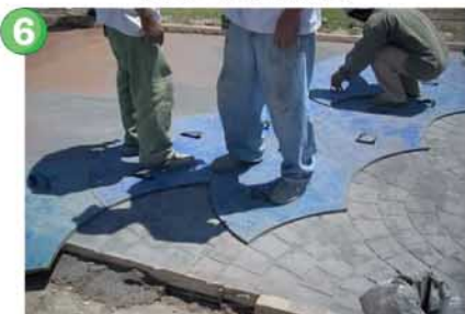
Colocación de moldes *ARQUIMAT y aplicación de estampado.
