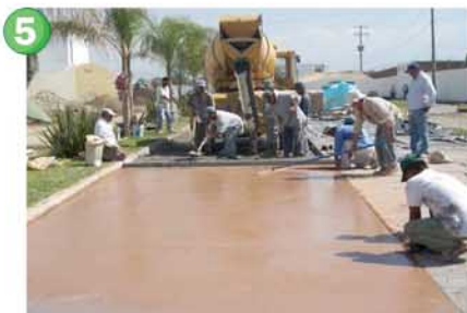
Aplicación de *DESMOLDANTE IMPRESSION en polvo para dar color al piso y facilitar la separación de los moldes del concreto.
