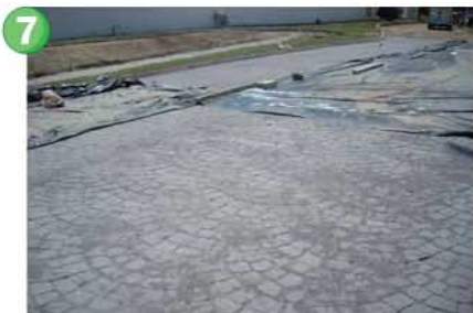
Colocación de Polietileno como curado de concreto y protección contra lluvias durante 24 hrs.
