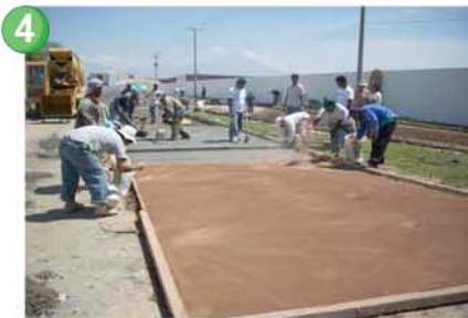
Regleado y aplicación de endurecedor en polvo *ARQUIHARD .
