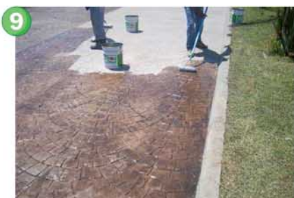
Aplicación de barniz *ARQUISEAL : Sellador protector para evitar la absorción de aceites y manchas.
