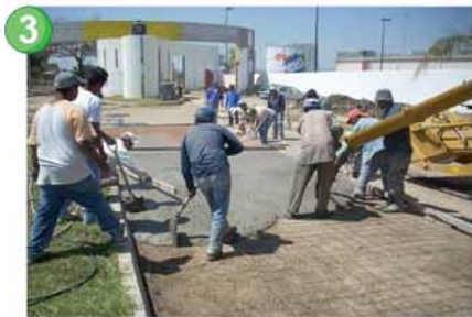
Vaciado de Concreto y Nivelación.
