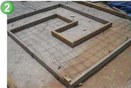
Armado Estructural y Cimbrado.
