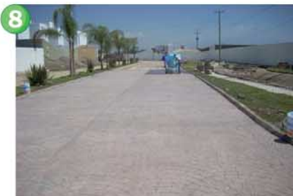
Lavado de piso para eliminar el exceso de desmoldante IMPRESSION .
