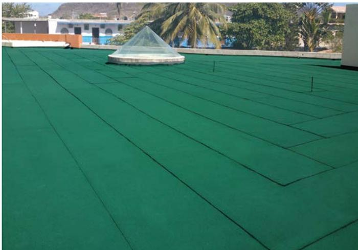
Membrana impermeabilizante fabricada con asfalto de alta calidad modificado con SBS, de gran resistencia a los agentes atmosféricos, a los contaminantes y a los rayos del sol. Con buena flexibilidad y desempeño. Reforzado con fibra de vidrio de 90 gr/m<sup>2</sup>.
