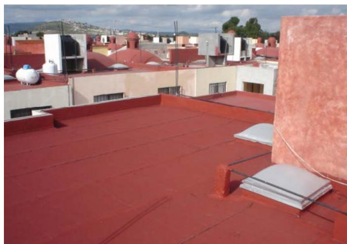
Manto impermeable fabricado con asfalto de alta calidad modificado con SBS que brinda las propiedades de: flexibilidad y resistencia a los rayos UV reforzado con fibra Poliéster Spunbond de 180 gr/m<sup>2</sup> o fibra de vidrio de 90 gr/m<sup>2</sup>. Es ideal para todo tipo de climas.
