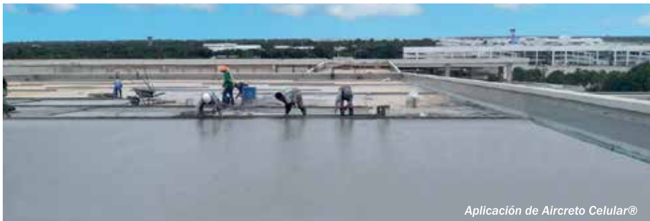
Aplicación de Airecreto Celular®
