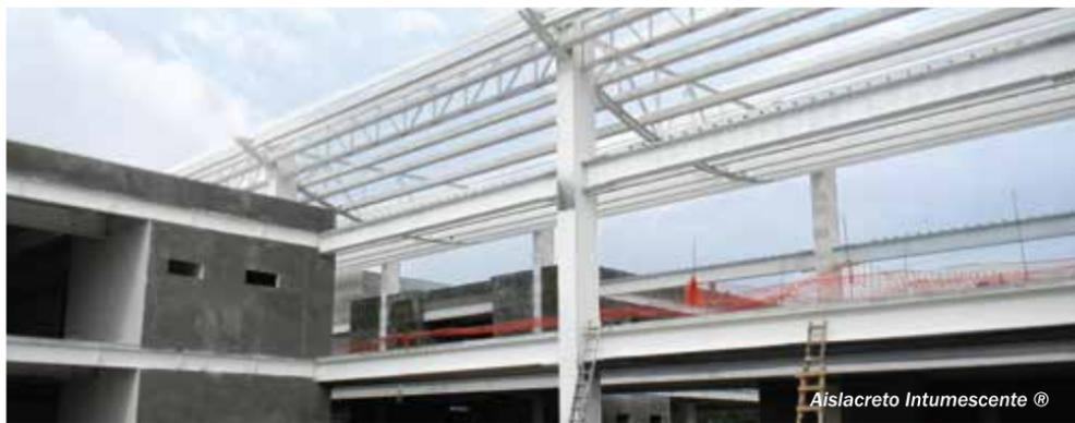
**Aislacreto Intumescente®** son unos recubrimientos retardantes de fuego de un componente, en base agua o solvente, protegen el acero estructural, láminas metálicas y en general cualquier elemento metálico, de las edificaciones.
